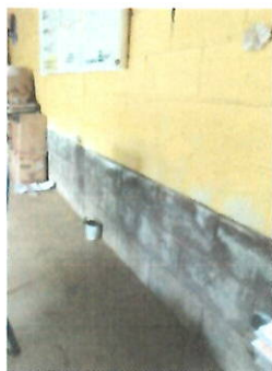
PINTURA, APLICACIÓN DE PINTURA EN MODULO 1 Y MODULO 2
