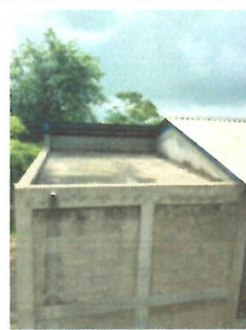
IMPERMEABILIZACIÓN DE LOSA POR EMPOZAMIENTO Y FILTRACIÓN
