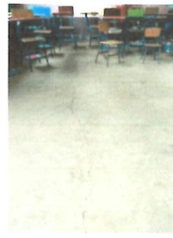
PISO SUSTITUCION DE TORTA EN MAL ESTADO POR PISO EN MODULO 1, AULA 1 MODULO 2
